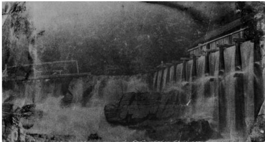
Figur 35: Nedre Möllans vattensåg med ränna och träfördämning. Inga-Lill Pehrsson, Varberg.
