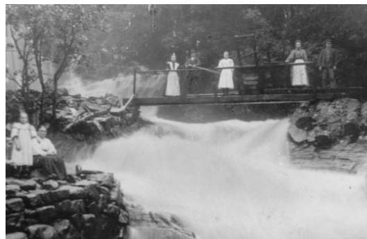
Figur 38: Högvatten vid sågen och samtliga luckor är dragna. Mannen längst till höger är Nils Pehrsson, en av initiativtagarna till Vessige Kraftverk. Inga-Lill Pehrsson.
