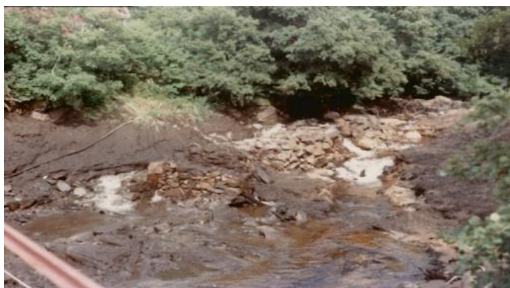
Figur 15: Kyrkokvarns fallsträcka i samband med anläggningsarbeten 1984. Vid fototillfället råder lågvattenföring om cirka 0,2 \text{ m}^3/\text{s} . Vebro Industris arkiv.
