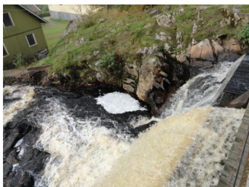
Figur 52: Norra bergväggen vid Mellanmöllans fallkrön. Notera den bågformiga urgröpningen vid vattenlinjen under den utskjutande klippan. Ett resultat av mångårig erosion?
