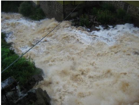
Figur 24: Medströmsvy över Mellanmöllan vid högvatten. Vattnet mellan fallen är kraftigt turbulent utan skyddande höljor.
