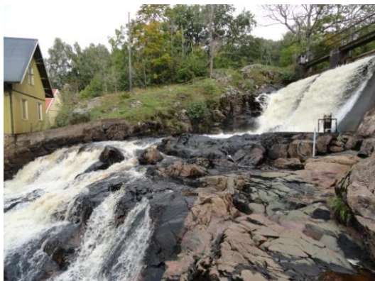
Figur 42: Ledarmen till Mellanmöllans kvarnränna omedelbart nedströms dagens dammbyggnad. Ledarmen är delvis täckt med en slityta av betong. Intaget fanns till vänster i bild.
