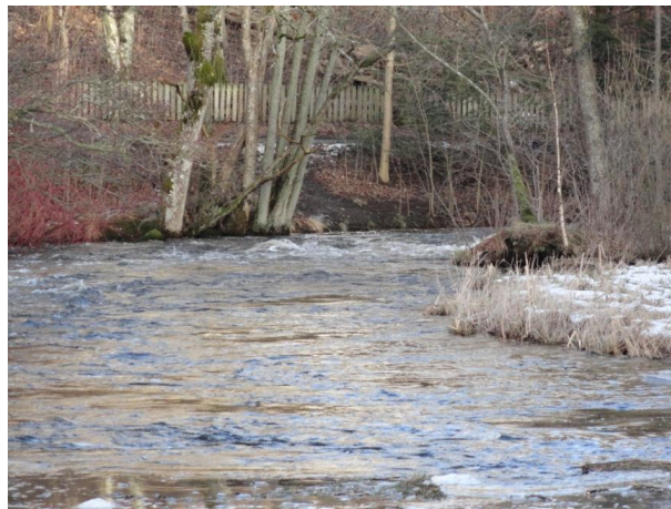
Figur 22: Inloppet till dammen sett från dammbyggnaden vid tillrinning om 9 \text{ m}^3/\text{s} . Vattnet faller ett par dm från den trånga sektionen ner i dammen. Nivån i dammen är fullt lagliga + 30,86.
