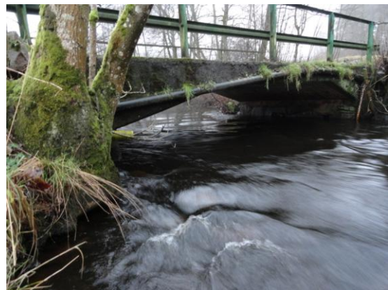
Figur 19: Strömfallsfastighetens gräns 300 m uppströms dammen vid 3 \text{ m}^3/\text{s} . Vattnet strömmar obehindrat och börjar nästan forsa nedströms bron.
