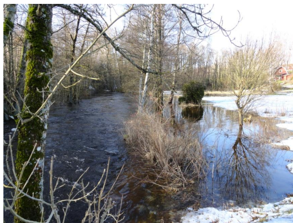
Figur 3: Cirka 300 m uppströms dammen korsas ån av en mindre bro. På åns högersida finns en privatägd trädgård som översvämmas vid högre flöden. Flödet i ån är cirka 9 m 3 /s. Henrik Jacobson 2012
